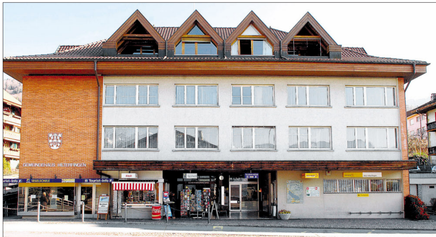
Umzug im gleichen Gebäude: Die Post an der Staatsstrasse 18 (rechts im Bild) in Hiltefingen zügelt ins Tourismusbüro (links). Ab 30. April können Kunden dort ihre Einzahlungen machen und Briefe und Pakete abgeben.
